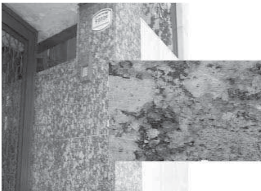
Figura 1 – Alteração na cor - Granito Amarelo Florença
