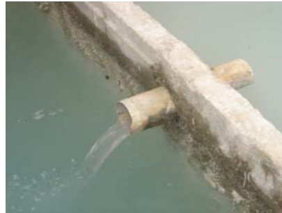
Foto 3: Entrada no último tanque
