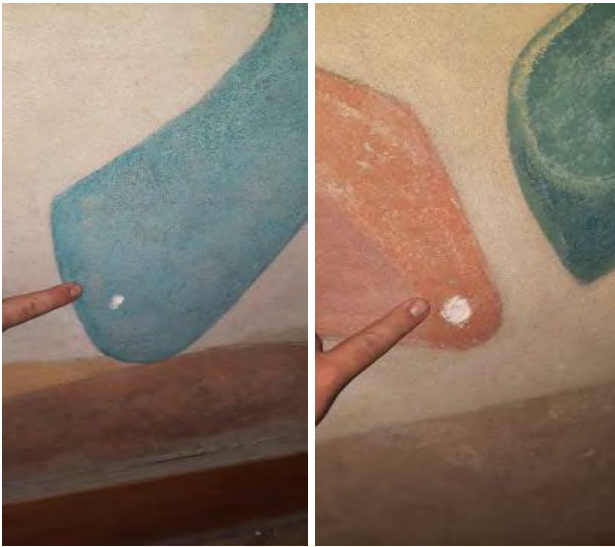
Figura 6. Perdas de massa da obra “Escola de Canto”.
