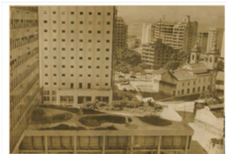
Figura 5. Jardim do terraço do segundo pavimento do edifício do Ministério da Educação e Saúde como inicialmente construído, s/d. [c. 1944]. Fonte: ACI/RJ.
