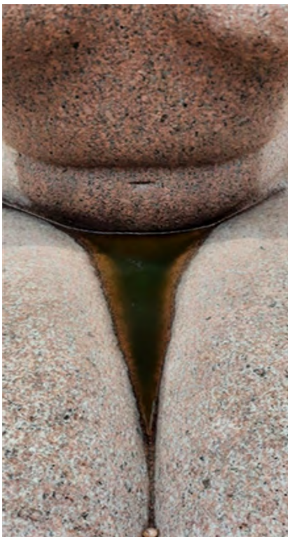
Figura 24. Acúmulo de água, dejetos e colonização biológica.
