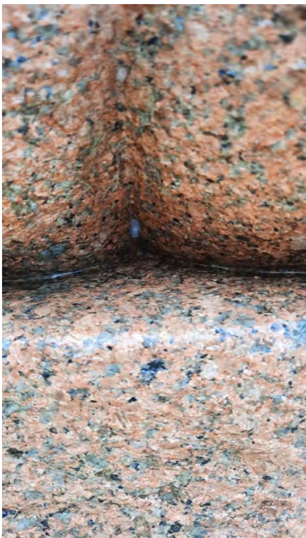
Figura 28. Presença de propagação microbiológica (aparente bolor, fungo).
