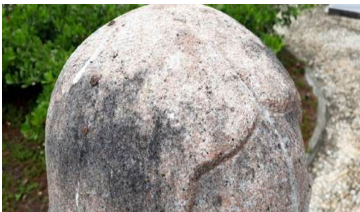
Figura 26. Formação de pitting, gerado por perda de material, e buracos no topo da cabeça.
