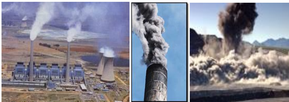
Figura 1.13 Fuentes de contaminación del aire por partículas (polvos) y gases
