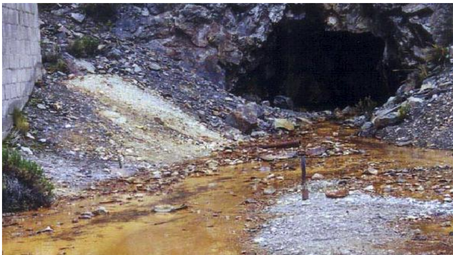
Figura 1.11 Contaminación ambiental mediante aguas ácidas (Boca de mina Dólar , mina abandonada de Tres Paisanos Huancavelica – Perú, Vidalón J., 2001)
