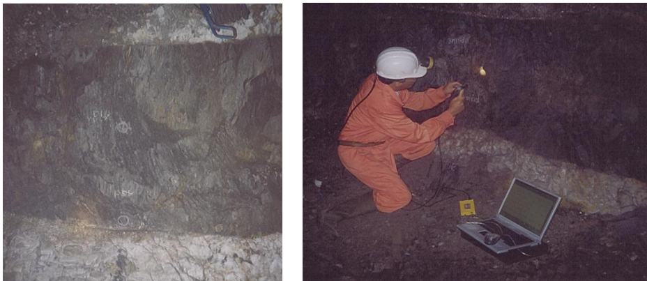
Figura 8.65 Mediciones con Sonic Integrity Testing de los daños provocados por el explosivo en los hastiales de la cámara L3.D19.R-3.AW34 (entre los puntos topográfico 31 y 35)
