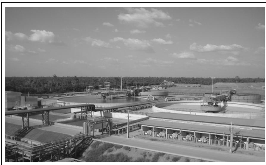
Figura 2 – Espessador do rejeito de flotação de usina de beneficiamento de minério.
