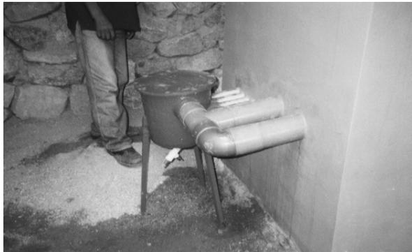
**a.5) Tuberías de retorno y desfogue,** dos tubos de PVC en paralelo de 4" pulgadas de diámetro que comunican la tasa de recolección con el extractor cerrando el circuito de aire.
