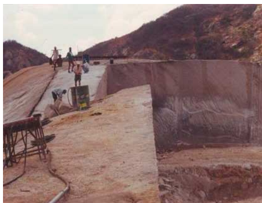
Figura 3 – Aspecto da pedreira do granito Rosa
