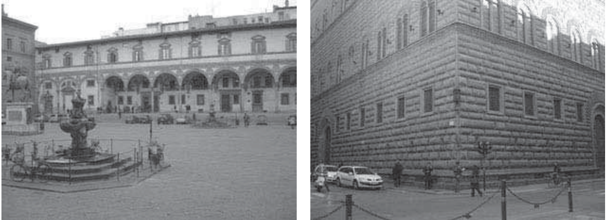
Figura 1. Exemplos da utilização do arenito “Pietra Serena” na arquitetura da Cidade de Florença. Hospital dos Santos Inocentes (esquerda); Palazzo Grozzi (direita).
