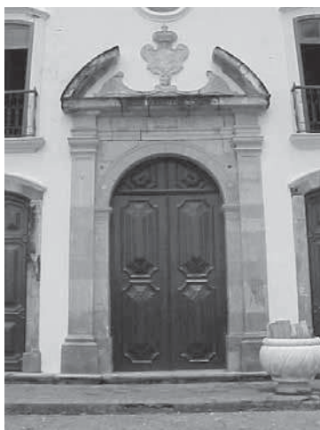
Figura 4* - Portada Central em arenito; frontispício - Igreja de Nossa Senhora do Amparo – Olinda/PE.
