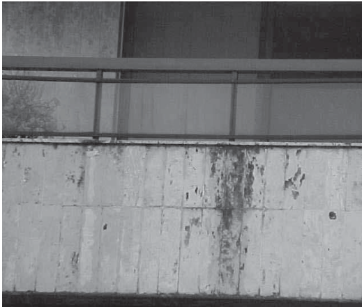
Figura 6: Mármore Travertino (Crosta) Fonte: Silva, S.A.
