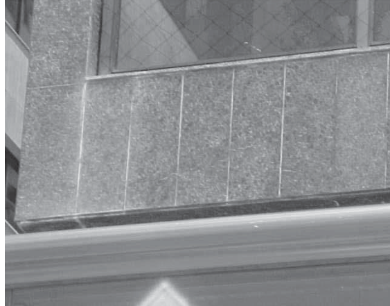
Figura 7: Granito Marrom Imperial (Eflorescência) Fonte: Silva, S.A.
