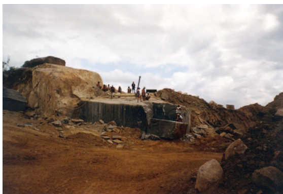
FIGURA 5 - Detalhe da operação de furação com quarry-bar no maciço rochoso
