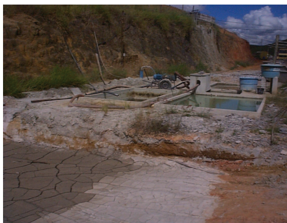
FIGURA 2 – Ao fundo, Unidade de tratamento de resíduos em serraria de Santo Antônio de Pádua. Na parte inferior da Figura, observa-se a pré-secagem do resíduo sólido, após a remoção do mesmo dos tanques de sedimentação.
