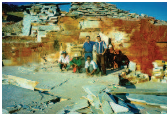
Figura 6 – A figura mostra as lajes de grandes dimensões obtidas com detonação realizada aplicando as novas técnicas de desmonte.
