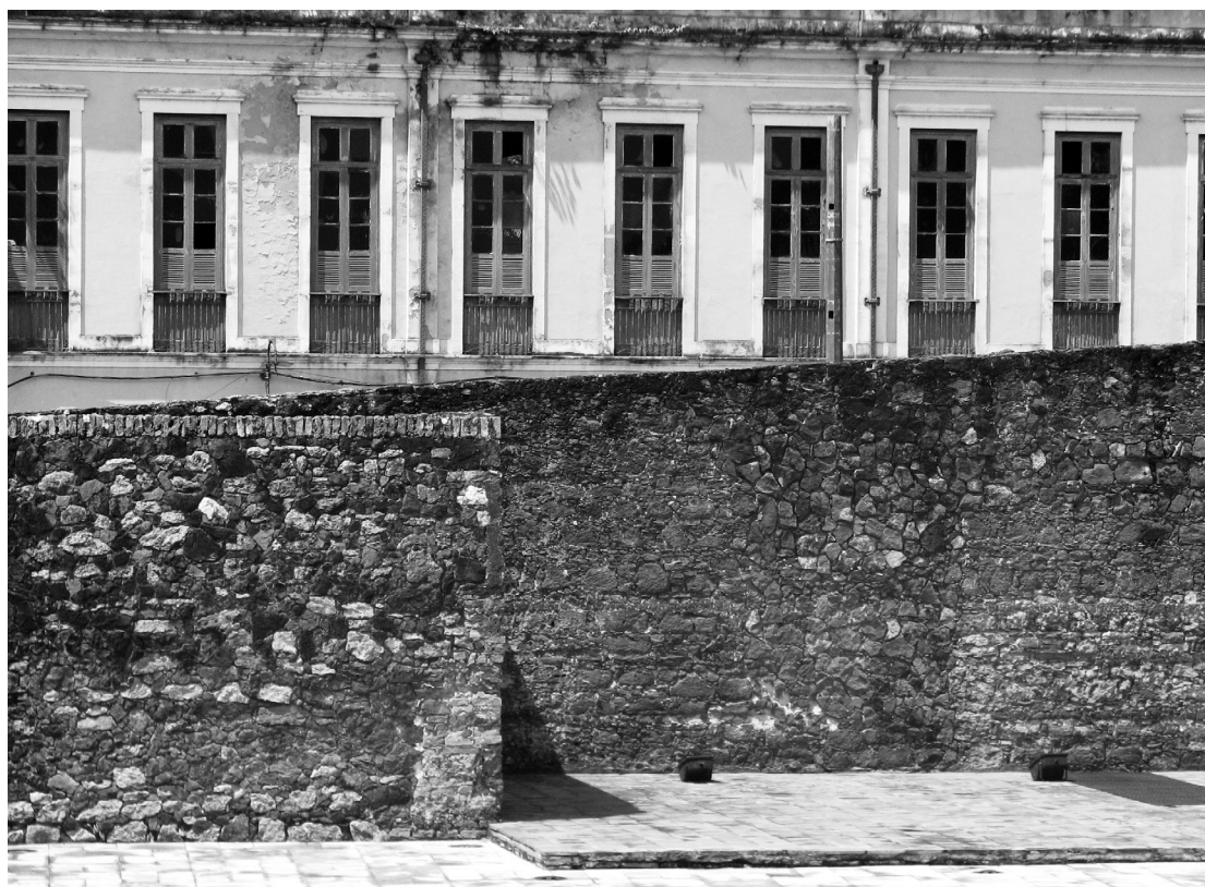
Figura 5 - Muro construído com pedras irregulares, hoje ligadas com argamassa. Foto: M.H.B.O. Frascá.
