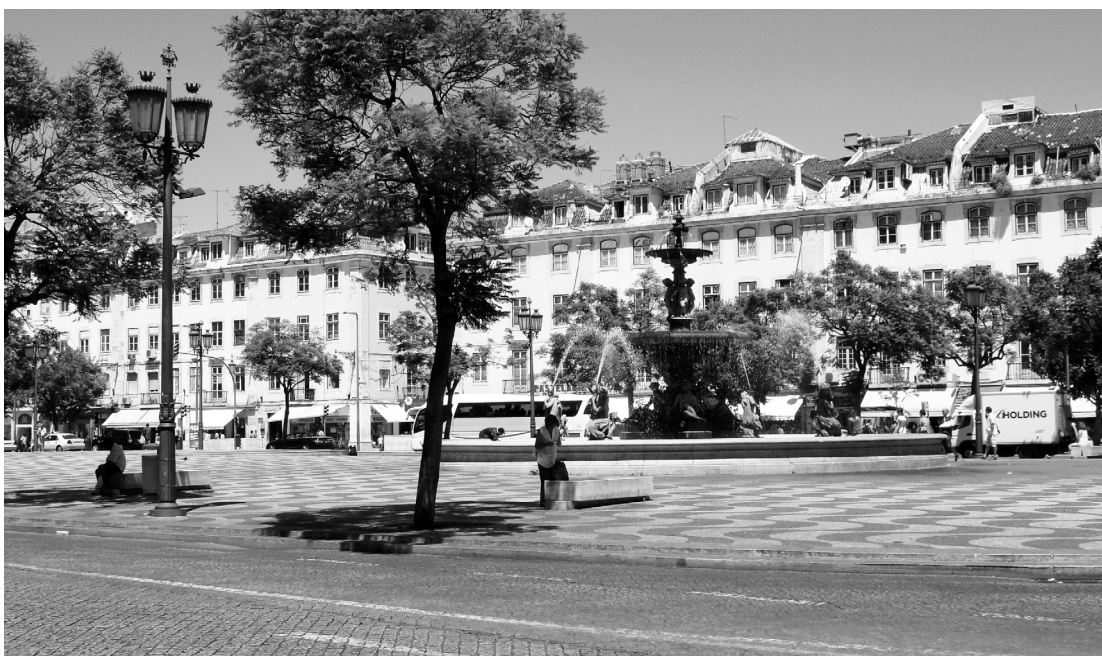
Figura 9 - Exemplo de aplicação da rocha na pavimentação de rua e passeio público. Foto: M.H.B.O. Frascá.
