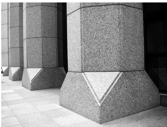
(c) Pilares revestidos com placas de ladrilhos polidos de rocha granítica.
