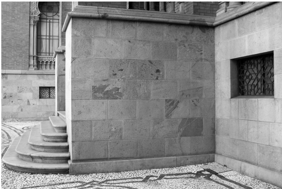
Figura 6 - Base em alvenaria de pedra talhada, com acabamento apicoado. Castelo Mourisco, Rio de Janeiro (RJ). Foto: M.H.B.O. Frascá.
