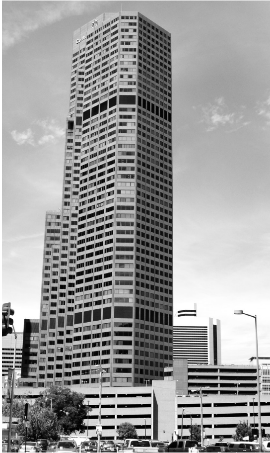
(a) Edifício com fachada inteiramente revestida com placas de rocha polida.
