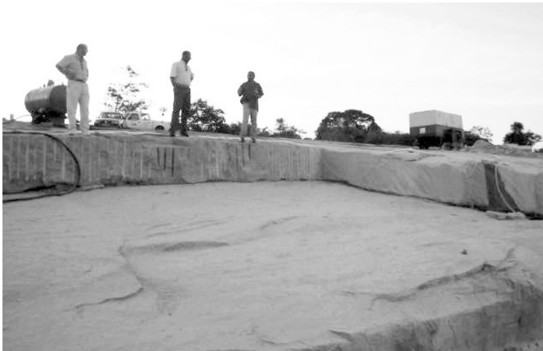
Figura 1 - Abertura de frente de lavra na Pedreira Escola da CBPM, em Ruy Barbosa – BA. Foto: CETEM/MCTI, 2002.
