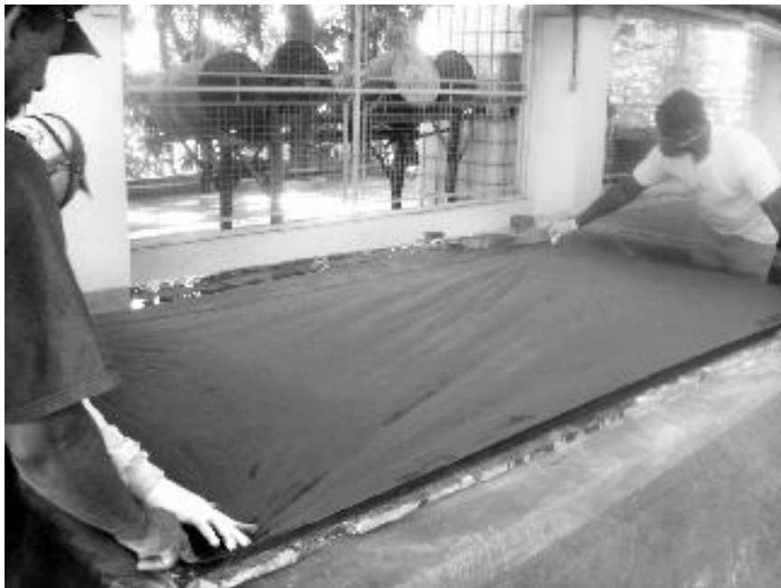
Figura 48 - Aplicação do tecido na chapa. Foto: CETEM/MCTI, 2009.
