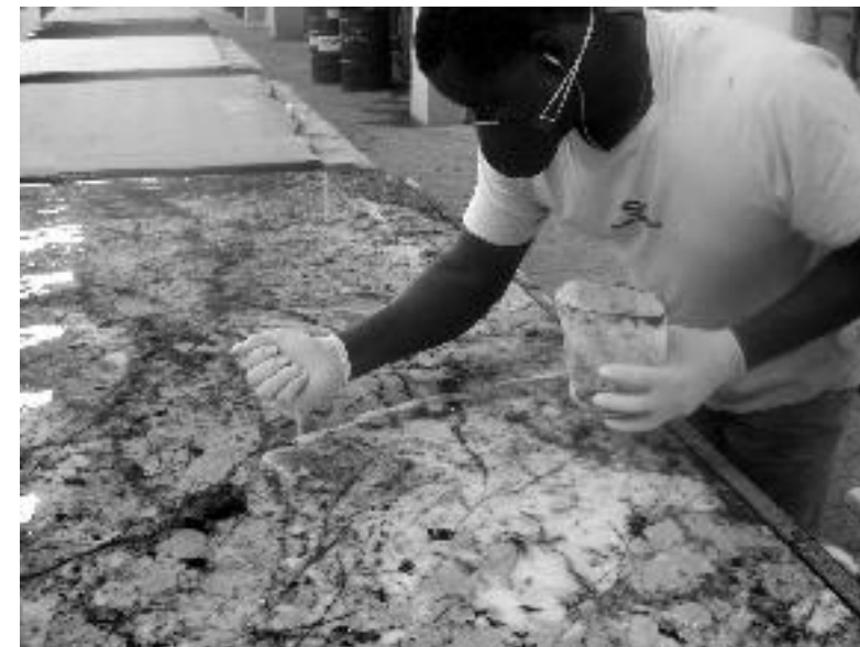
Figura 42 - Estucamento numa chapa com fissuras abertas. Foto: CETEM/MCTI, 2009.
