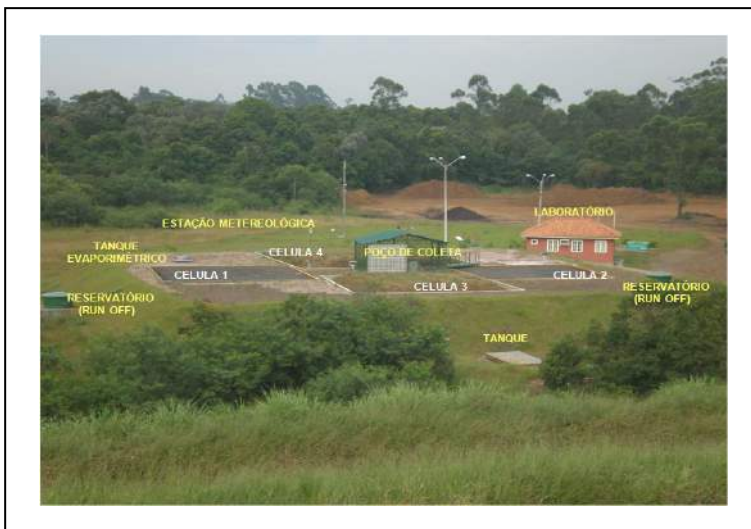
Figura 2. Vista geral da EEJPB.
