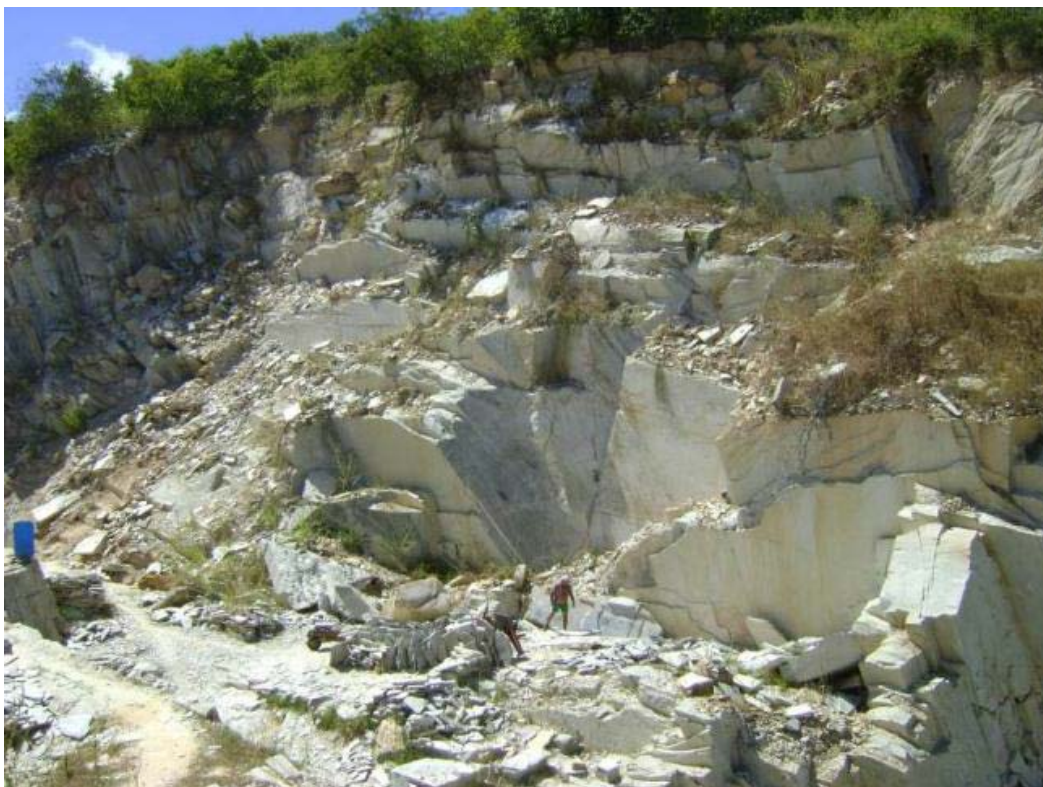
Figura 3 - Frente da Pedreira com Talude Negativo. Fonte: CDRM
