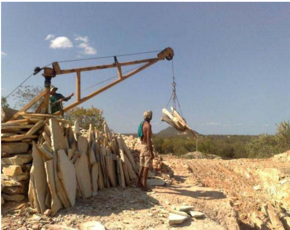
Figura 8 - Guincho utilizado para erguer as placas da base da cava a superfície. Fonte: CETEM/MCTI
