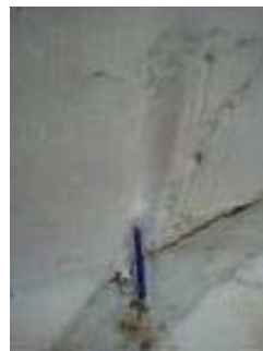
Figura 6 - Deposição de material devido à solubilização.
