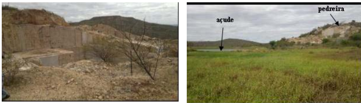
Figura 6 - Pedreira Saco da Serra: empilhamento de rejeitos finos (foto da esquerda) e bacia do açude parcialmente assoreada com plantação de capim (foto da direita).
