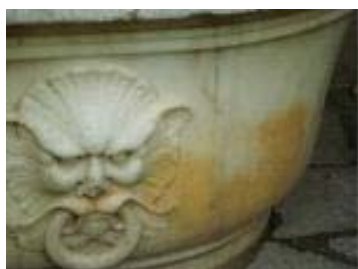
Figura 4 - Manchas causando a modificação da coloração.
