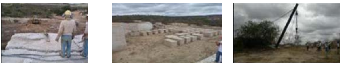
Figura 5 - Tombamento e armazenamento de blocos e pau de carga
