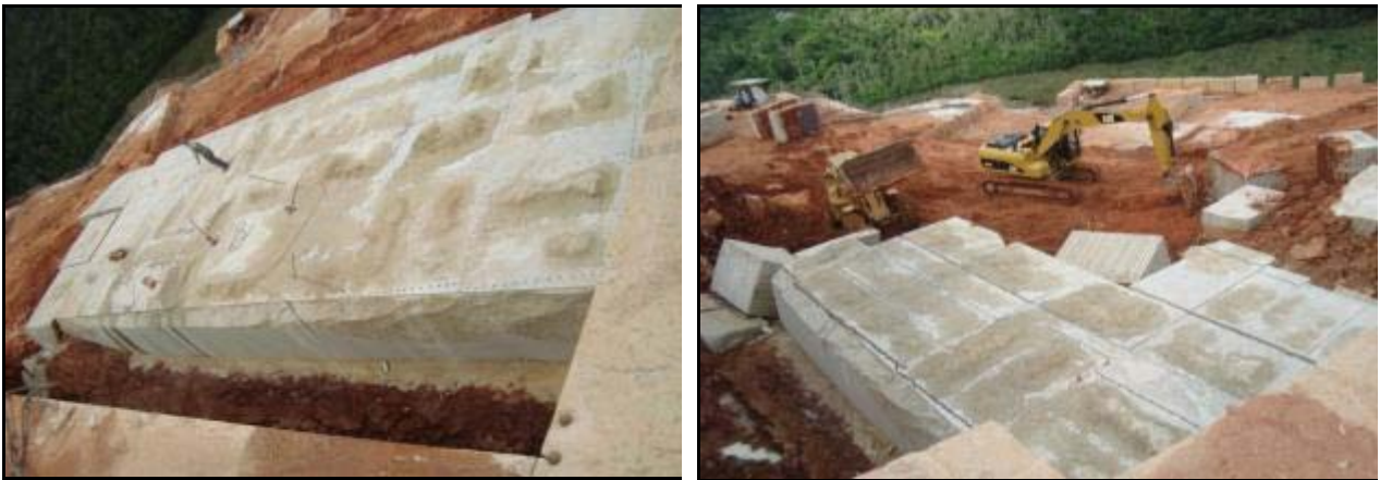
Figura 2 - Prancha sendo esquadrejada em blocos com a utilização de explosivos
