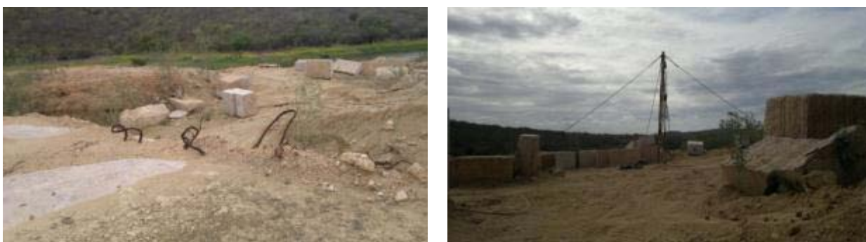
Figura 5 - Pedreira Saco da Serra: cabos de aço para tombamento dos blocos (foto da esquerda) e pau de carga (foto da direita)
