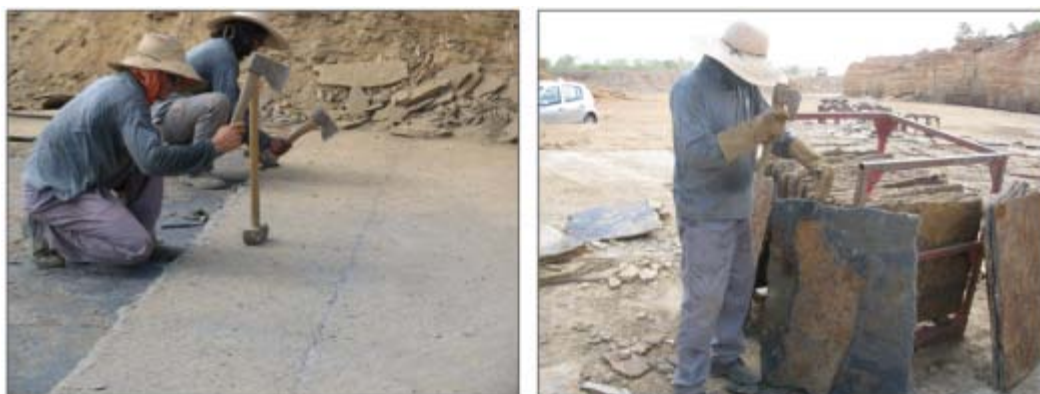
Figura 1 – Processo manual de retirada dos ladrilhos de Pedra Morisca.
