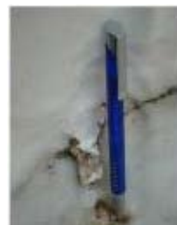
Figura 6 - Deposição de material devido à solubilização.
