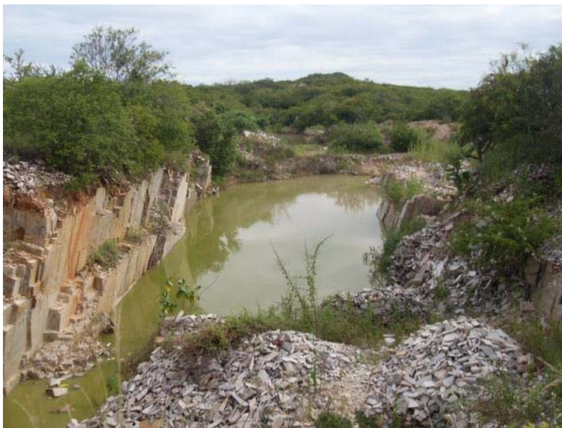
Figura 1 - Problema de alagamento das jazidas enfrentado nos períodos chuvosos. Foto: Diego Sales, Junho/2011.
