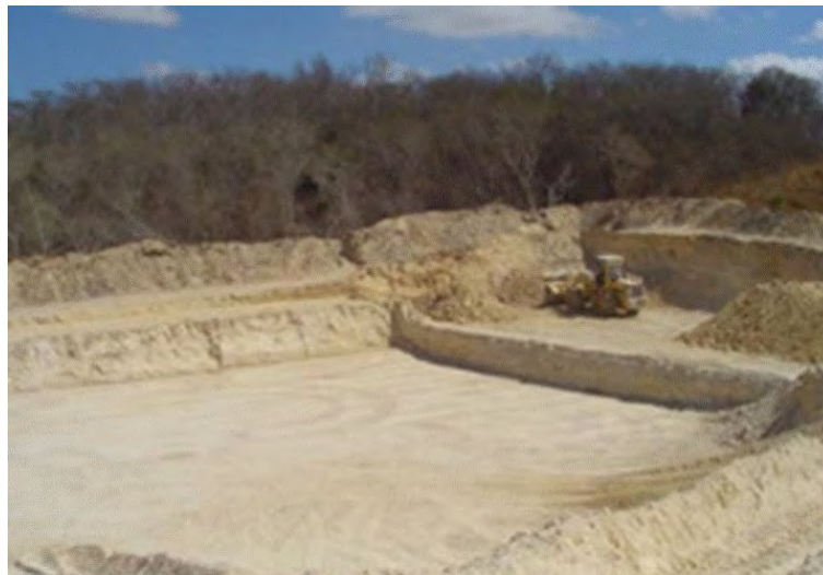
Figura 3 - Vista da jazida da área do empreendimento.
