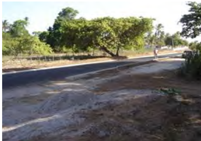
Figura 2 - Estrada de acesso à área da unidade de britagem.
