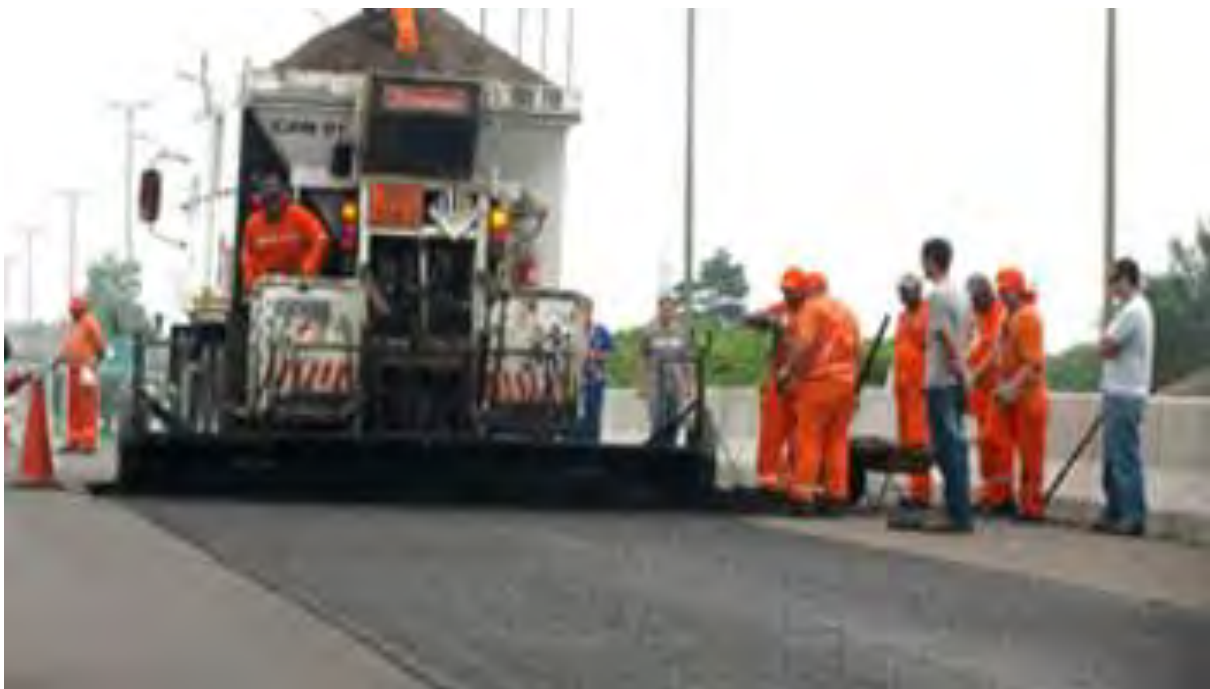
Figura 6 – Detalhe das obras de Duplicação da BR 101.
