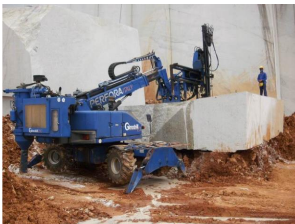
Figura 2 – Perfuratriz Girodrill 200 em operação na pedreira
