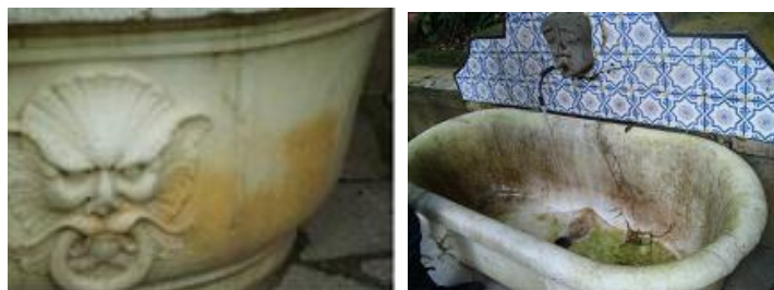
Figura 5 – Manchas causando a modificação na coloração
