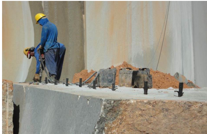
Figura 6 - Operação de bate cunha criando um plano de fraqueza na rocha para seu fraturamento em uma direção
