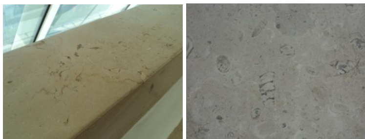
Figura 3 – Pontos resinados e fósseis em revestimento do Museu do Amanhã (Elaboração dos autores)
