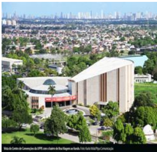
Figura 2 - Foto do Centro de Convenções, UFPE
