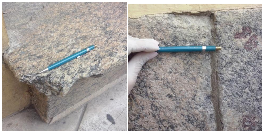
Figura 4.1.2: Fraturas e fissuras encontradas nas rochas
