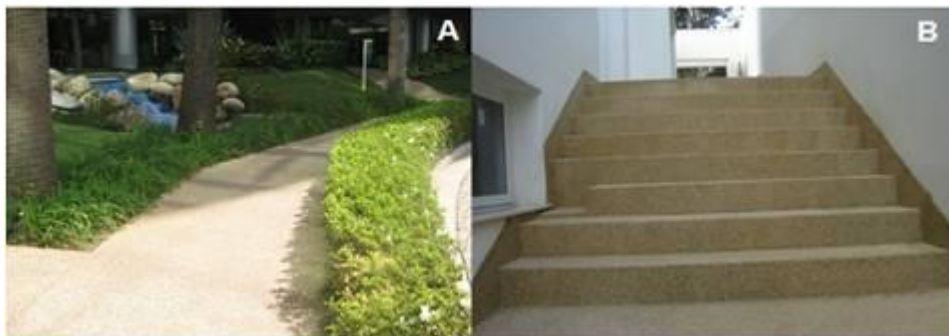
Figura 7 - Aplicação de material britado em piso na forma de Fulget
