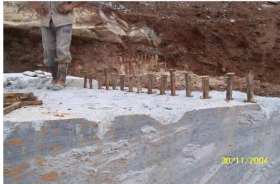
Figura 1 - Furos com cunhas metálicas. Fonte: Almeida, 2006.
