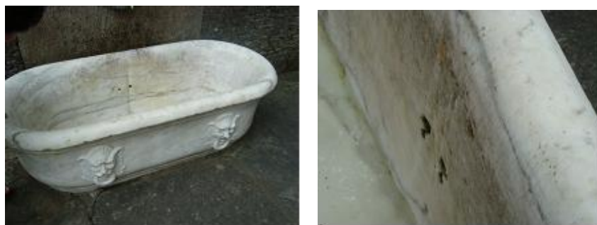
Figura 4 – Perda de massa rochosa devido a dissolução em meio ambiente quimicamente agressivo
