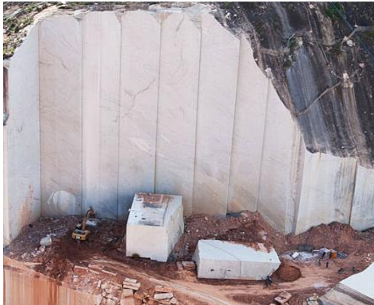
Figura 1 – Bancadas com mais de 60 metros de altura (Fonte: MINERAÇÃO GUIDONI, 2016).
