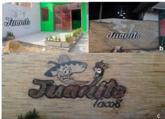
Figura 5 - Aplicação de cacos e aparas na montagem do painel vertical (logomarca do Juanito tacos).
