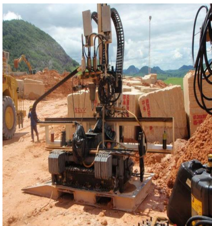
Figura 3 – Perfuratriz MPL-3M em operação na perfuração de gnaisses ornamentais
