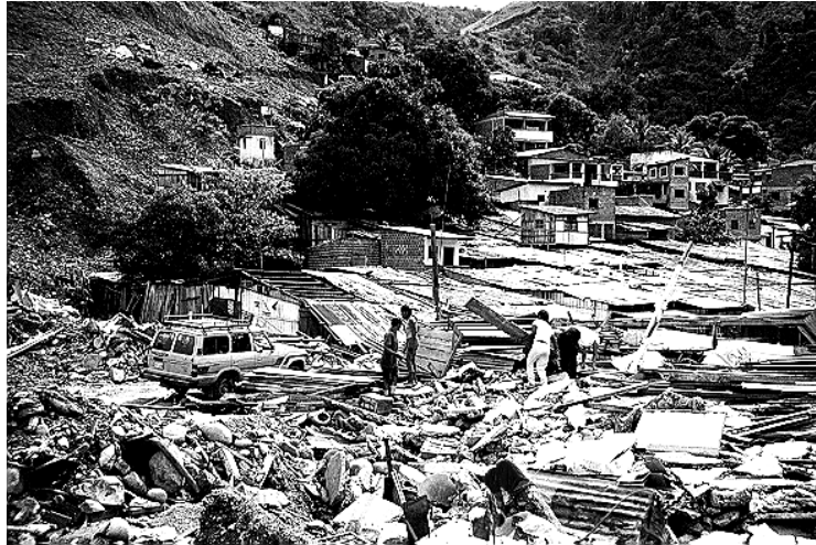
FOTO 11. Entrada a Chima por la calle Sorata. La gente intenta recuperar materiales
