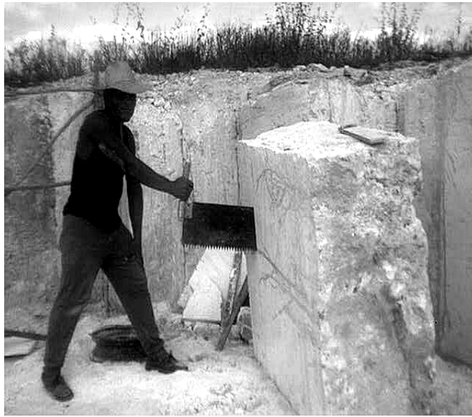
Foto 4 - Detalle del Seccionamiento de un Bloque de "Canto" En "Chapas" Mas Pequeñas
