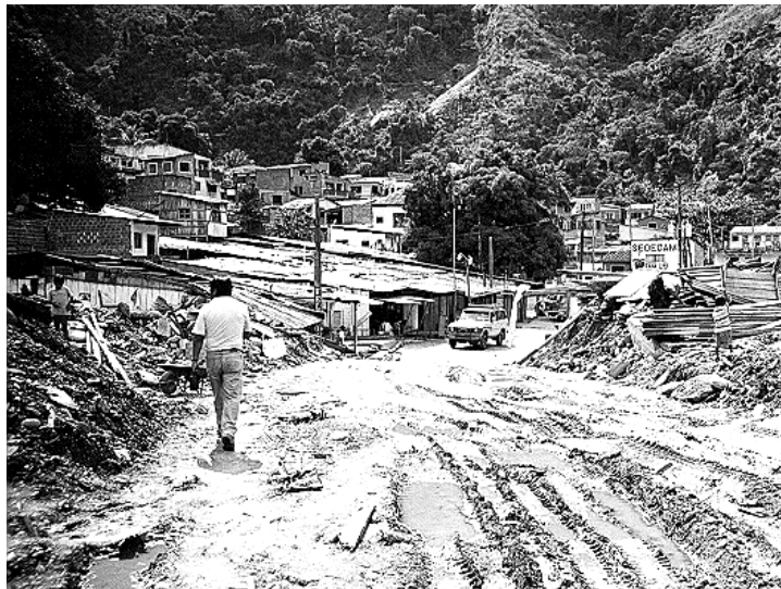
FOTO 6. Entrada a Chima por la calle Sorata, en la zona arrasada por el alud. Es la zona de casas de la FOTO 3. El cerro queda a la izquierda
