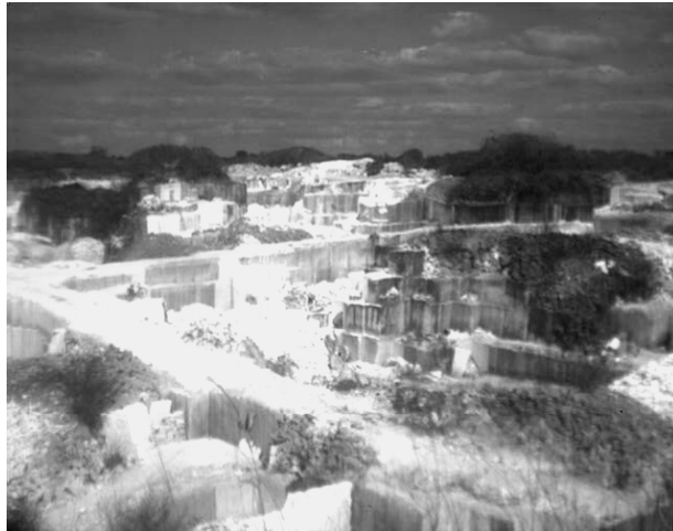
Foto 2 - Zona de extracción actual en el sector j-4 (flanco norte). obsérvese la altura excesiva del frente que comprende varios escalones de explotación. las flechas indican la acumulación de escombros que ha ido cerrando el avance de los frentes
