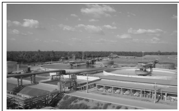
Figura 4. Espessador de rejeito de usina de beneficiamento de minério.
