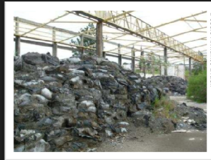
Avaré (SP): Depósito abandonado de lixo tóxico contendo amianto
