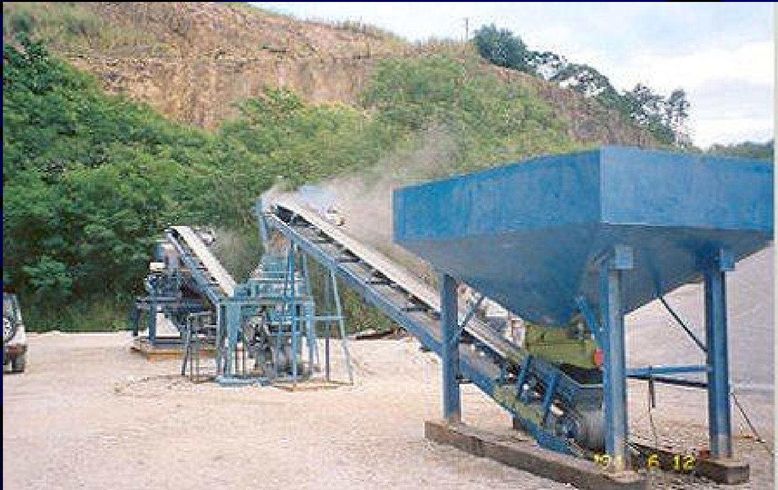
Figura 2 – Vista panorâmica da unidade piloto.
