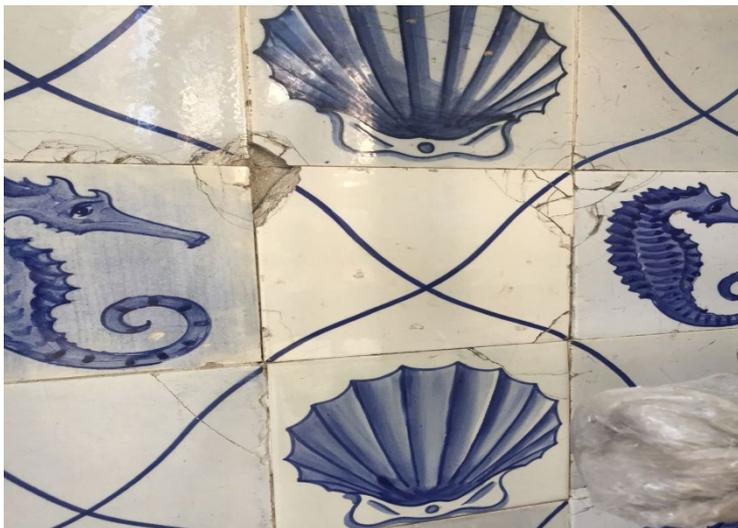
**Figura 22:** Trinca e fissuras.
