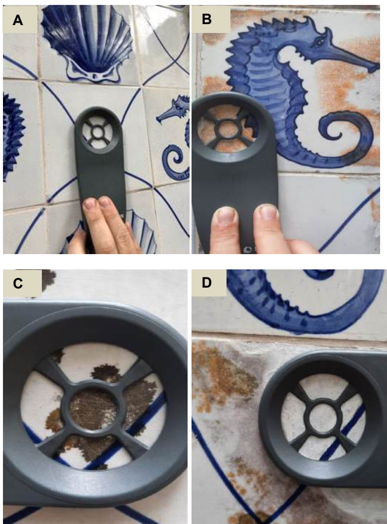
Figura 18: (A): Azulejo íntegro; (B) fungo rosa; (C) fungo negro e (D) azulejo perfurado.
