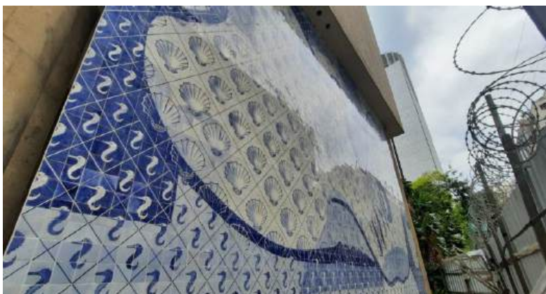
Figura 7: Visão geral do painel 3.
