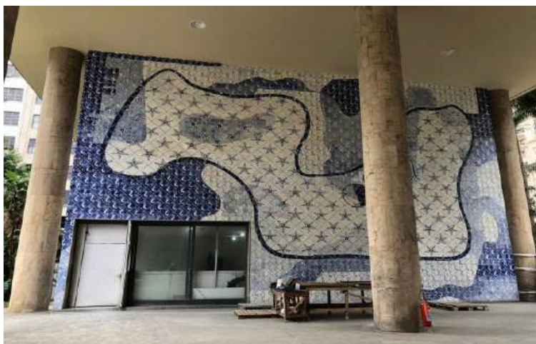
Figura 2: Visão geral do painel 1.
