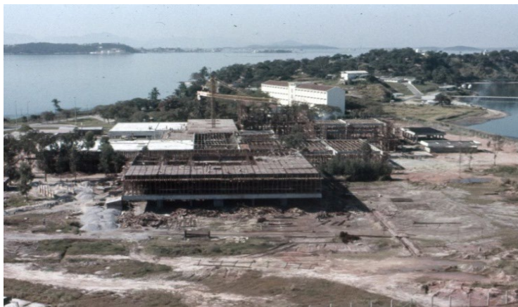
Figura 2. Início das obras de construção do CET.
