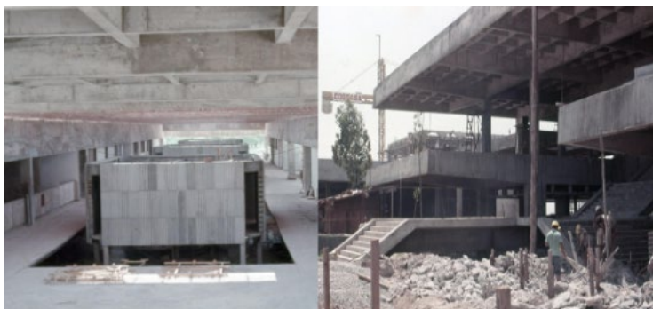
Figura 3. Concreto do Centro de Tecnologia Mineral, 1972-1978.
