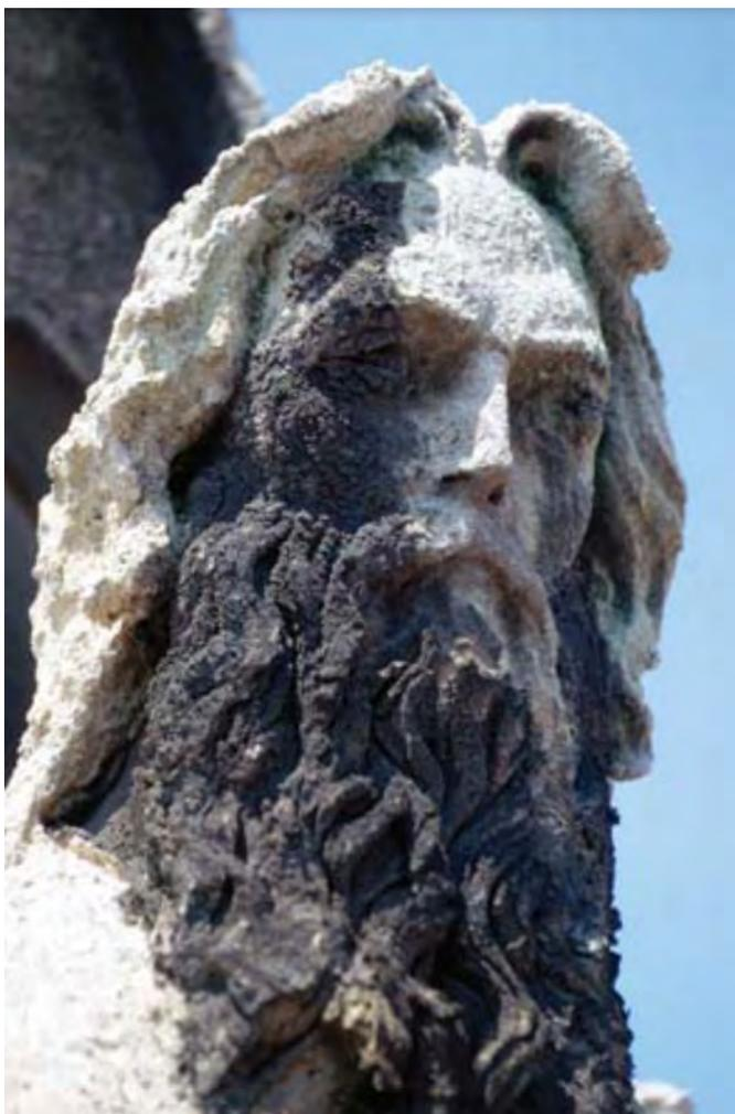
**Figura 6.** Obra apresentando crosta negra na Catedral de Namburg, Alemanha. Imagem retirada de: Illustrated Glossary on Stone Deterioration Patterns, ICOMOS, 2008, p.43.
