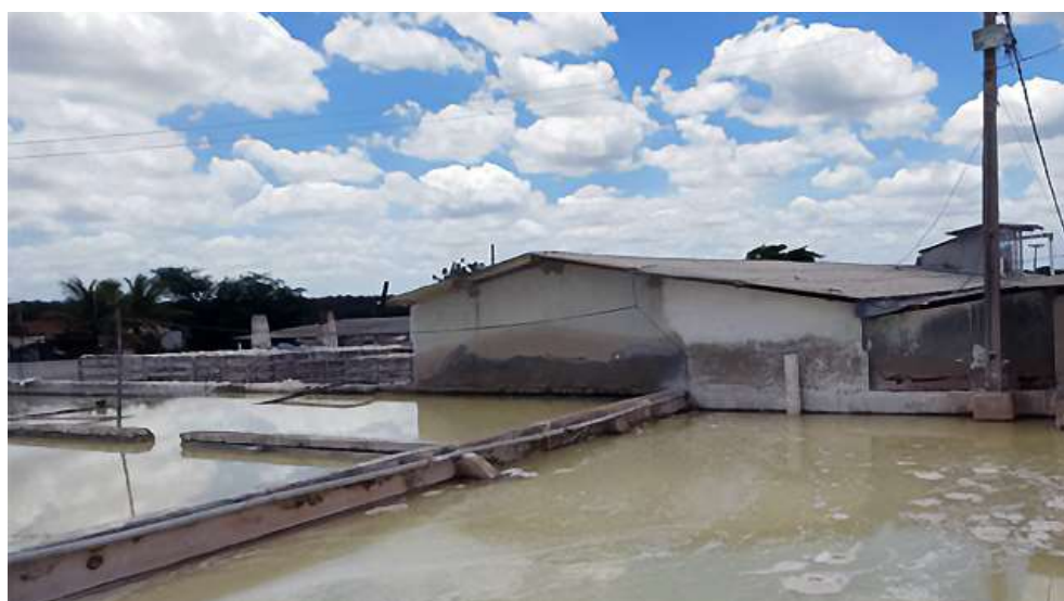
Figura 55: Tanques de sedimentação para reúso de água de processo, Juazeirinho, Paraíba. Foto: Suellen Marques.
