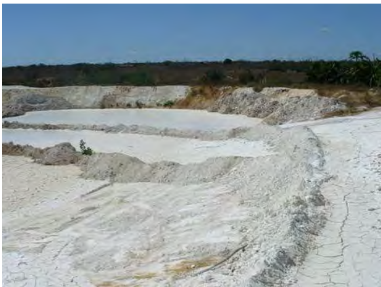
Figura 3: Depósito de resíduos finos do Mármore Bege Bahia.
