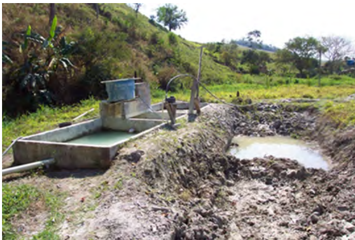
Figura 3: Tanques de decantação para o resíduo fino.
