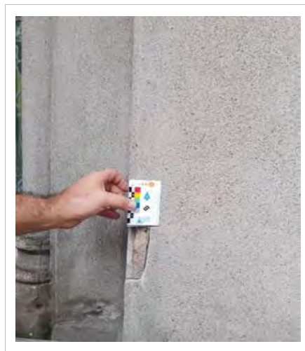
Figura 12. Retirada de amostra de argamassa do Ponto 8.
