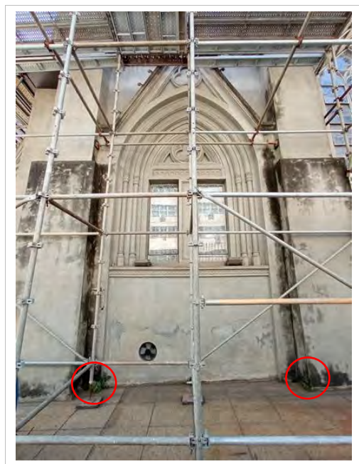
Figura 22. Presença de crostas negras, trincas, fissuras e crescimento de vegetação.
