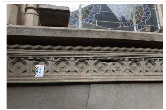
Figura 15. Fissuras e trincas na fachada (ponto 2).
