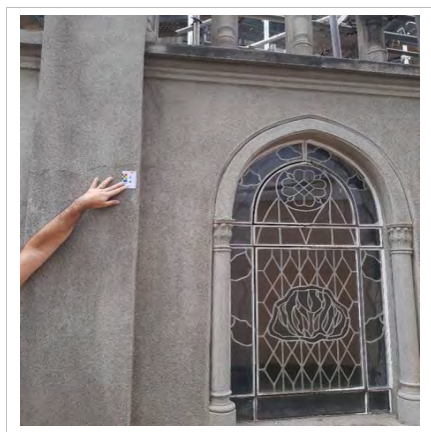
Figura 19. Fissura e crosta negra observada na fachada posterior no andar térreo da Catedral.
