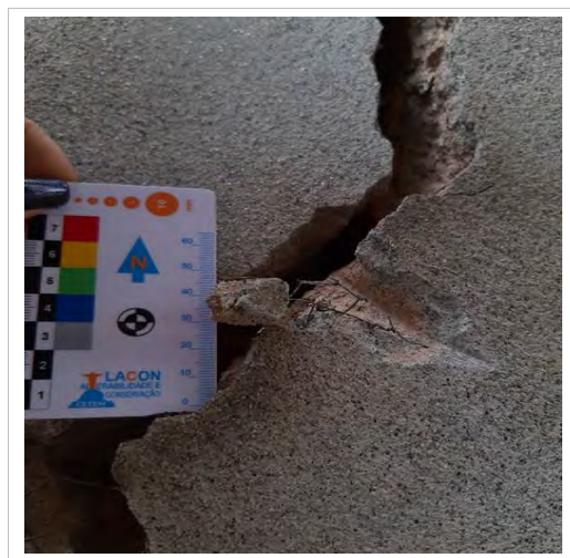
Figura 17. Tela metálica aplicada na argamassa da fachada lateral da Igreja.
