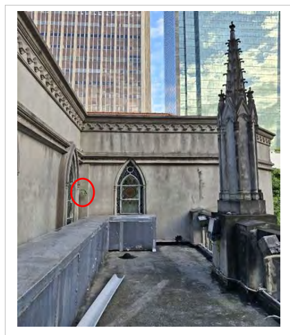
Figura 21. Presença de crostas negras, trincas, fissuras e crescimento de vegetação.
