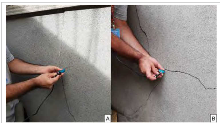
Figura 38. Extensão da rachadura, sendo (A) a área menos comprometida, e (B) a área mais crítica.
