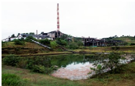
Pátio da Cobrac, extinta indústria que poluiu a cidade
