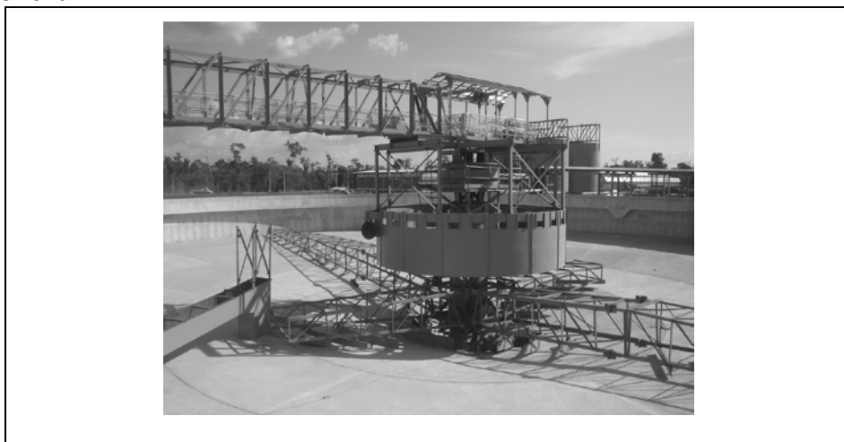
Figura 9 – Vista de um espessador industrial em fase de montagem.
