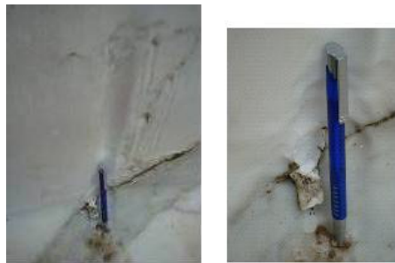
Figura 4.4: Deposição de material devido à solubilização.
