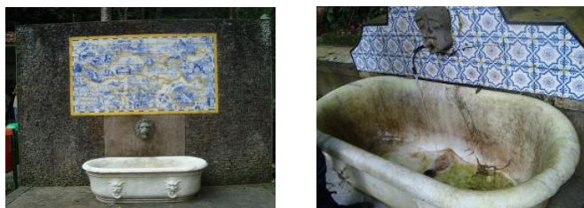
Figura 1.2: Banheiras em mármore em diferentes estados de deterioração
