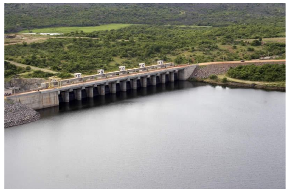
Figura 5 – Vista da barragem do açude castanhão.
