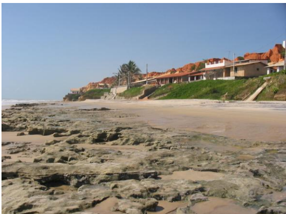
Figura 3 – Vista da plataforma de abrasão da Formação Barreiras na Praia de Morro Branco.
