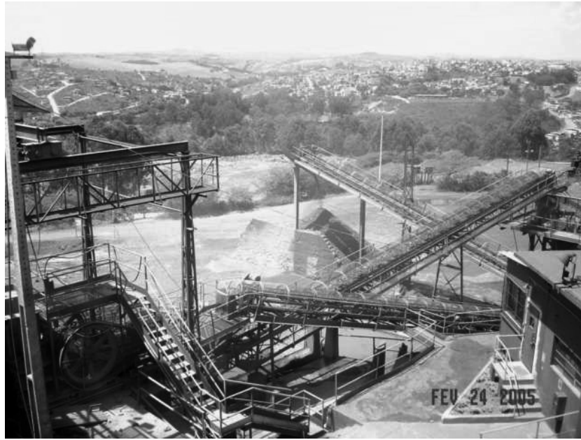
Figura 2: Planta de beneficiamento de Morro da Mina com vista parcial da cidade de Conselheiro Lafaiete (ao fundo). Salienta-se a necessidade de um controle eficaz da poeira e ruído devido à proximidade com a cidade.
