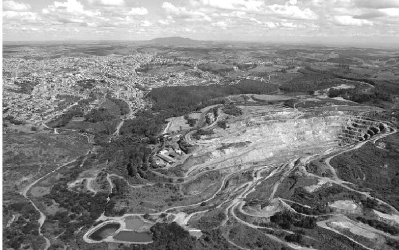
Figura 1: Vista geral da unidade Morro da Mina, destacando-se a cava a céu aberto e a proximidade da mina com a cidade de Conselheiro Lafaiete - (MG) (ao fundo)
