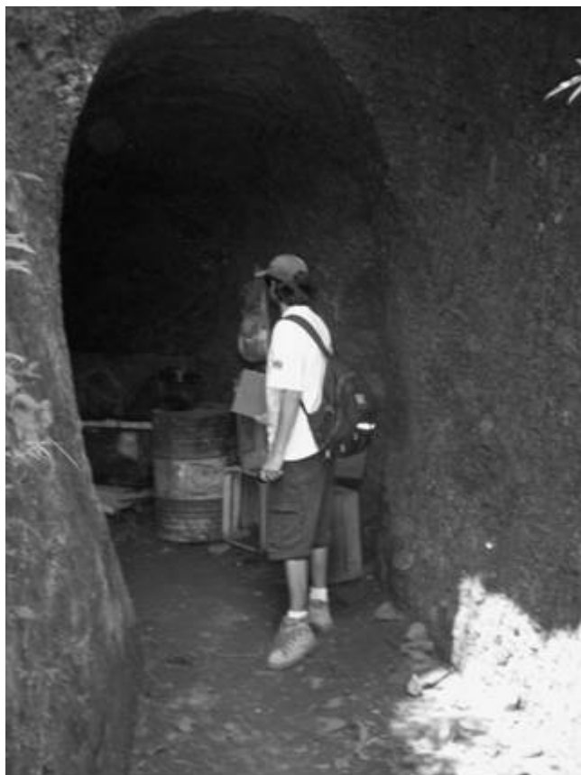
Figura 7: Canal de ligação entre mundéos utilizada atualmente como depósito
