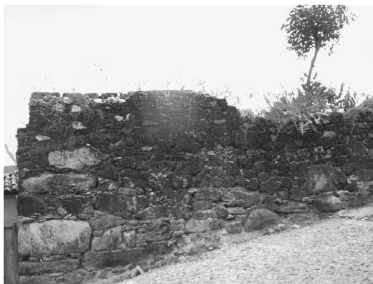
Figura 10: Fragmento de muro de pedra e argamassa no Bairro São Cristóvão.
