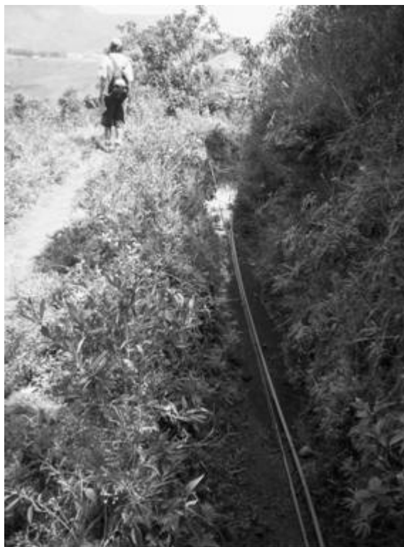
Figura 6: Trecho ainda preservado do aqueduto 2. Notar que a estrutura ainda hoje serve para condução de águas superficiais e base para instalações atuais
