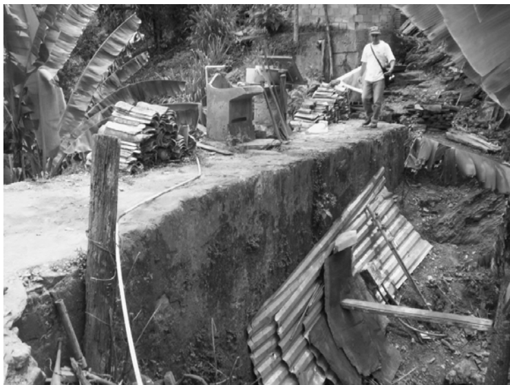
Figura 9: Detalhe de mundéo preservado em área totalmente ocupada.
