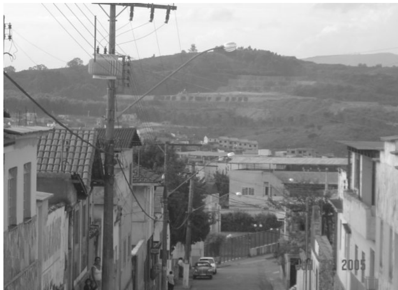
Figura 3: Foto de casario do Bairro Museu em Conselheiro Lafaiete evidenciando a proximidade entre a cidade e a pilha de estéril do Bambu , ao fundo.
