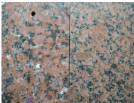
Figura 2 – Exposição ao dióxido de enxofre. Formação de sais em fissuras superficiais e, localmente, sobre biotita Nota: acima, corpo-de-prova de controle.
